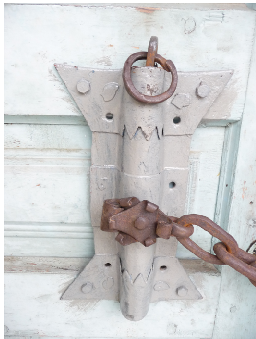
Рисунок. Кузнечный накладной замок. С. Кубачи. Дом Магомедова Джалила. Накладная часть покрашена.
