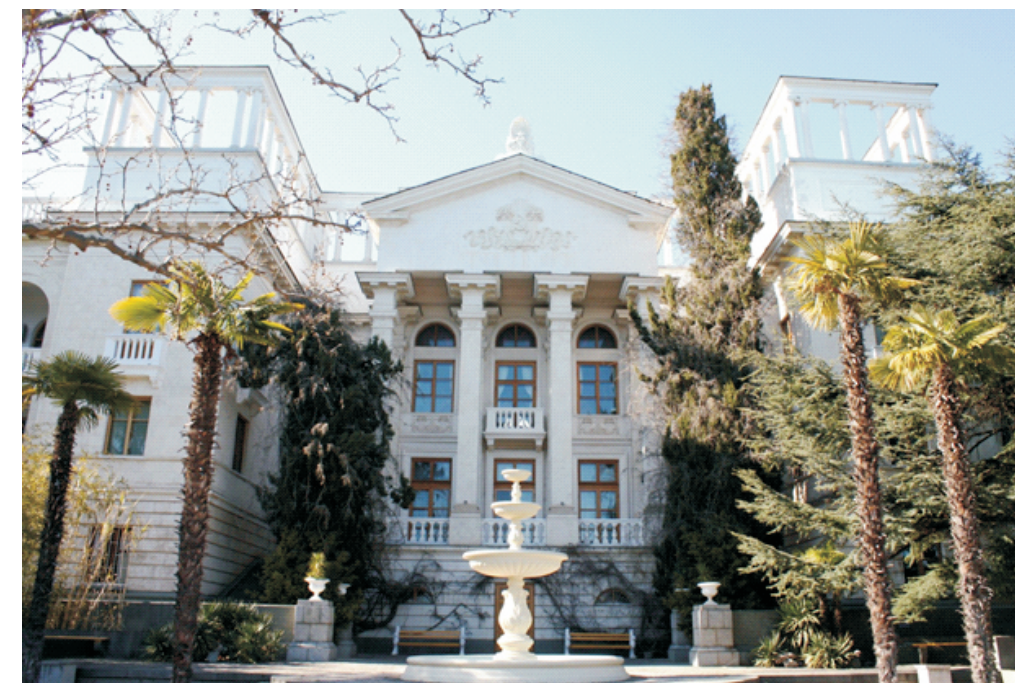
2. Санаторий «Россия» (1950 г., архитектор И.Г. Кузьмин), г. Ялта.
